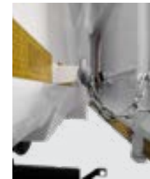
Der Windschutz verhin- dert das Schließen der Tür
