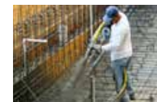
7 bis 12 bar: Spritzbetonanwendungen
