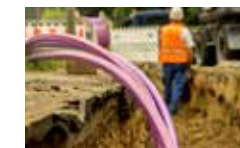
12 bar: Kabeleinblasen und Bohren
